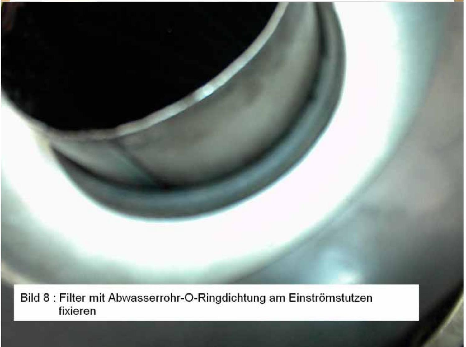
Bild 8 : Filter mit Abwasserrohr-O-Ringdichtung am Einströmstutzen fixieren
